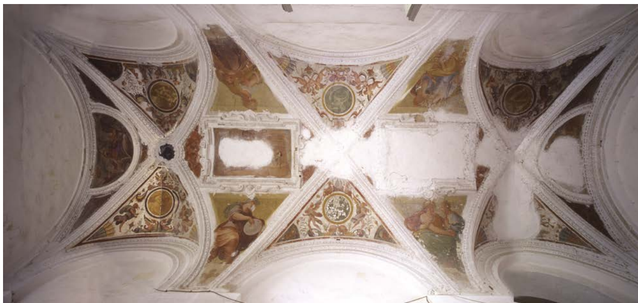
Figura 3. Caserta, Palazzo al Boschetto. Atrio delle Scienze e delle Virtù . Volta con quattro figure femminili allegoriche (nei pennacchi) e due scene superstiti del personaggio biblico di David (nel riquadro a sinistra il dettaglio di David che fugge dalla torre-athanor) (Fotografia di Luigi Santangelo).
